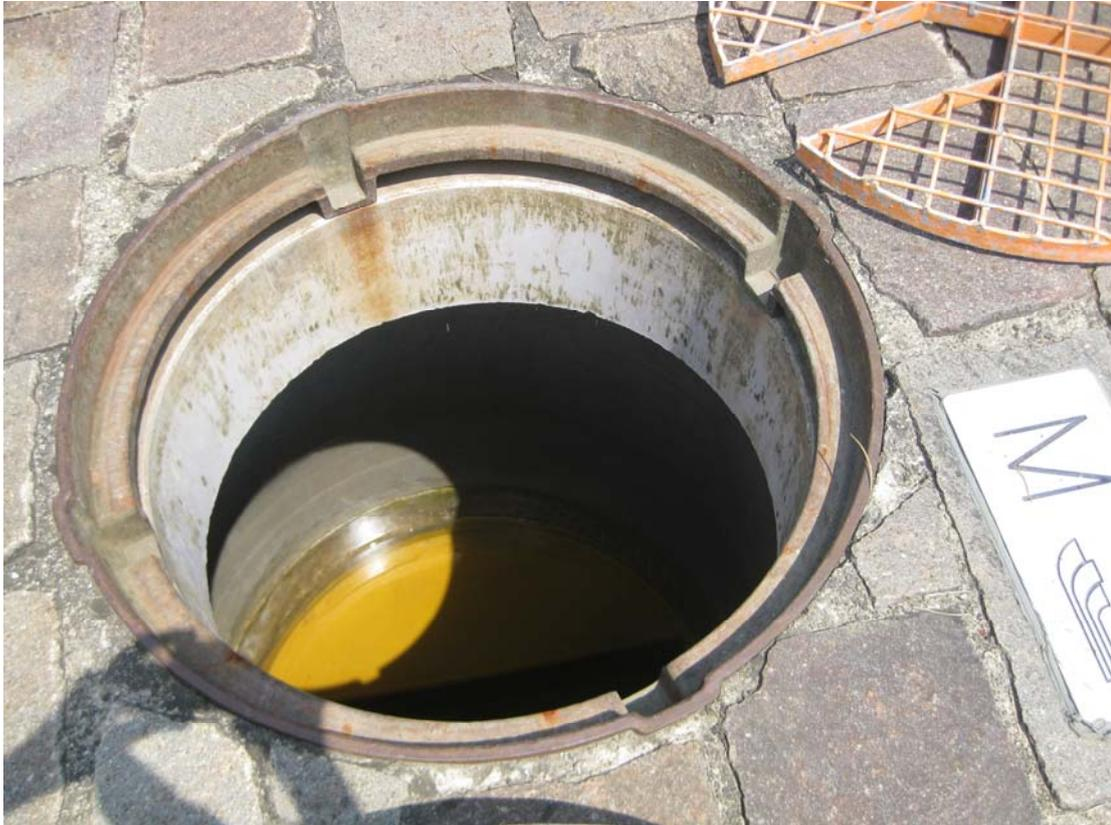
Abbildung 14.: Einstauhöhe im Schacht, 30 cm über erster Schachtfuge
