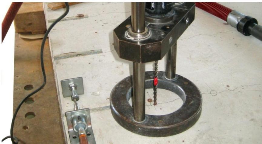
Abb. 31 Herstellung des Bohrlochs mithilfe eines Bohrständers
