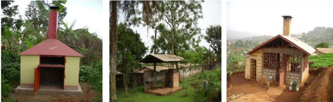
Abbildung 5 - Verbrennungsanlagen für medizinische Abfälle in Krankenhäusern in Kamerun (Maseko, 2014)
