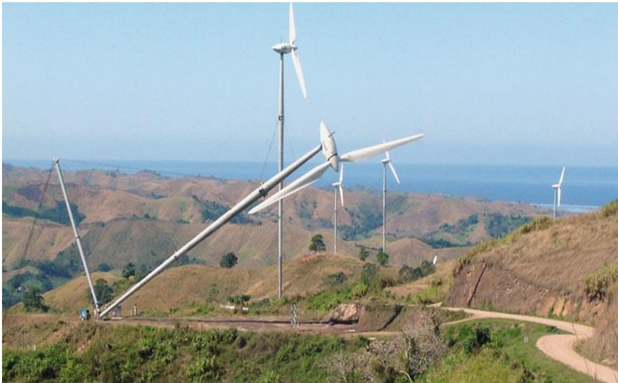
Abbildung 13: Kippbare mittelgroße Windkraftanlage des Typs GEV MP der Firma Vergnet (MEIR Green SRL, o.J., o.S.)
