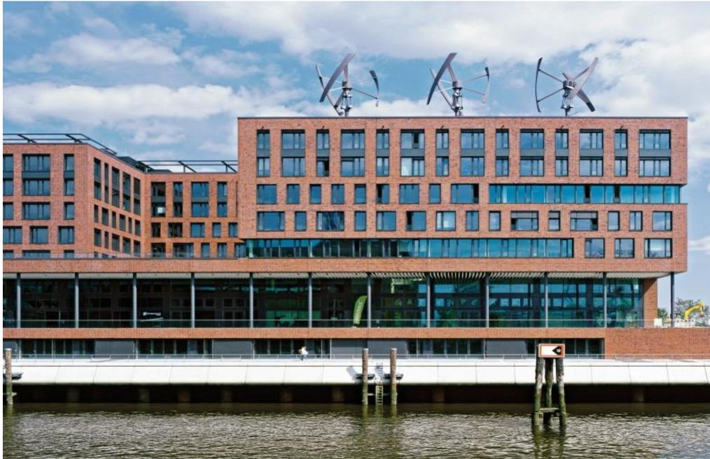
Abbildung 6: Drei Darrieus-Windkraftanlagen auf dem Greenpeace-Hauptgebäude in Hamburg (Deutsche Bauzeitschrift, 2015, o.S.)
