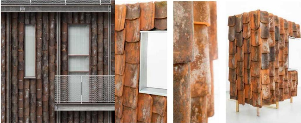
Abb. 5: Weiterverwendung von Dachziegeln als Fassadenverkleidung (Vandkunsten Architects, 2016).
