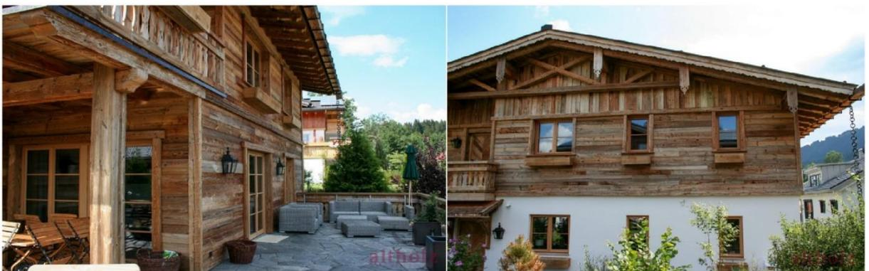
Abb. 9: Fassade errichtet aus wiederverwendeten sonnenverbrannten Brettern (altholz.net, 2020).
