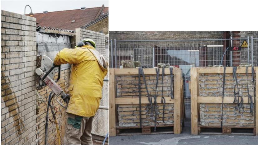
Abb. 21: Herausschneiden und Lagerung der Fassadenmodule (Lendager Group, 2020).
