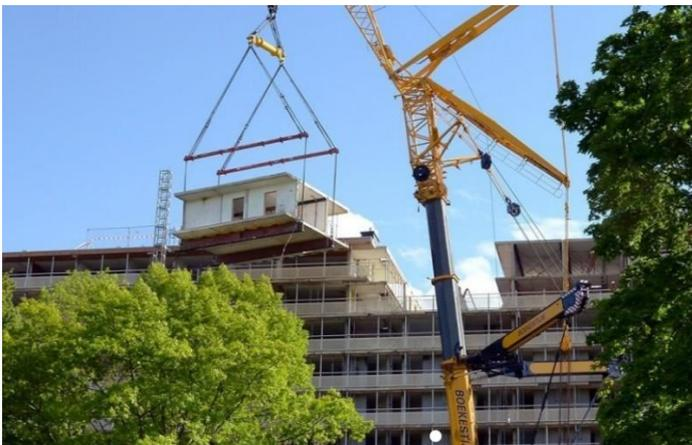
Abb. 11: Rückbau von Stahlbetonelementen eines Hochhauses (SUPERLOCAL, 2019).
