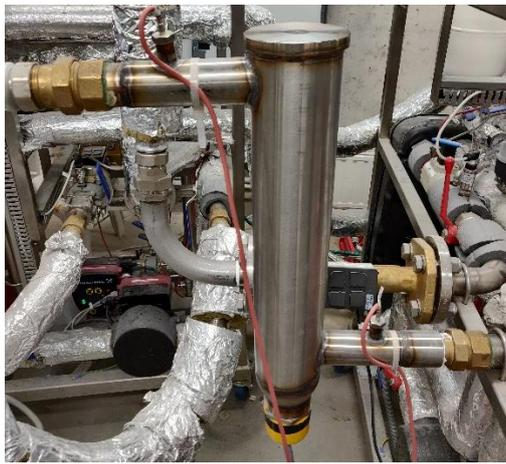
Abbildung 33: Heizstab mit Temperatursensoren T15 und T16
