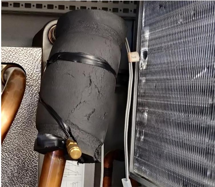
Abbildung 52: Temperaturmessfühler unter Armaflex-Isolierung
