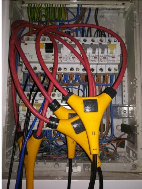
Abbildung 13 - Messaufbau im Sicherungskasten der Wohnung
