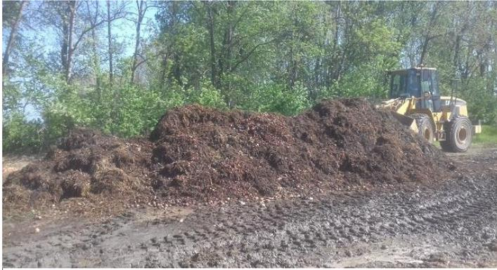
Bild 10: Aufschütten des Vorrotte-MC-Materials zu ca. 2 m hohen Trapezmiete
