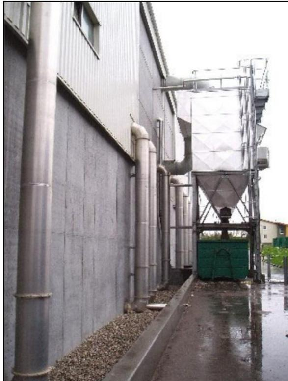
Abbildung 20: Staubfilter, Anlage St. Pölten (NEUBAUER und ÖHLINGER, 2006)
