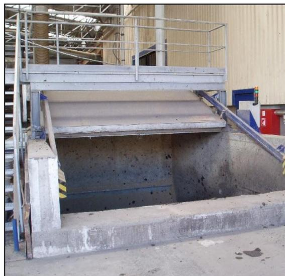
Abbildung 8: Klärschlambunker, Anlage Halbenrain (NEUBAUER und ÖHLINGER, 2006)
