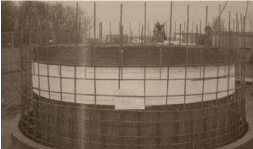
Abbildung 7.8: Senkscheide für 3m Schacht, man sieht die Innenschalung mit aufkaschierter Vließbahn, sowie das Fugenband (Nemeček, 2006)
