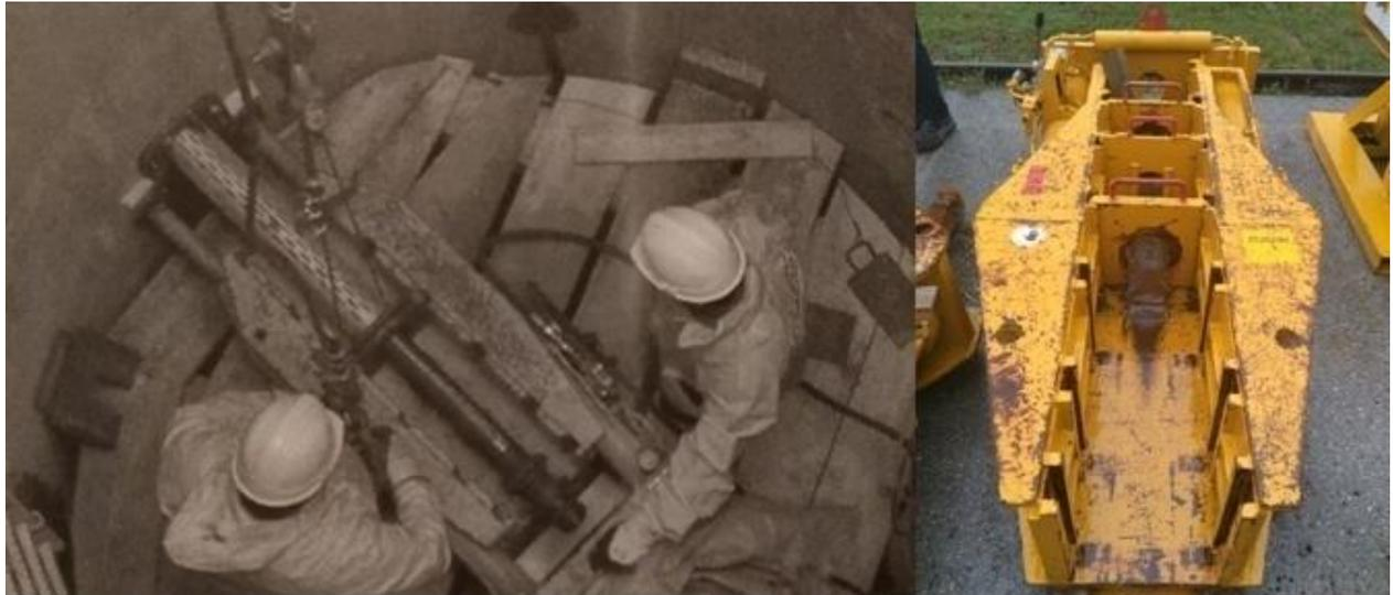
Abbildung 7.10: Vortriebspresse mit Filterrohr und Entsandungsgestänge beim Einbau (Nemeček, 2006) und Vortriebspresse am Bauhof
