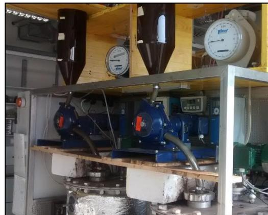
Abbildung 11: Einbringtrichter (oben) mit Peristaltikpumpe zur Dosierung des Einbringmaterials und Gaszähler
