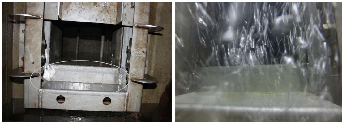
**Abbildung 30 Links: Einstiegsschieber in die Fischliftschleuse mit Versatz (Blick Richtung Fischliftschleusenschacht); Rechts: Einstiegsöffnung in die Fischliftschleuse mit Blasenvorhang auf Grund des zu 50 % geöffneten Bypasses (Blick Richtung Fischliftschleusenschacht)**
