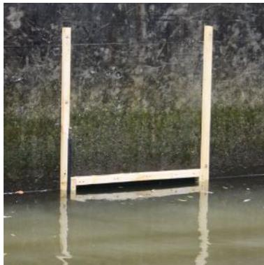
Abbildung 15 Absperrung des Einstieges in den Vorschacht der Fischliftschleuse für VAo1
