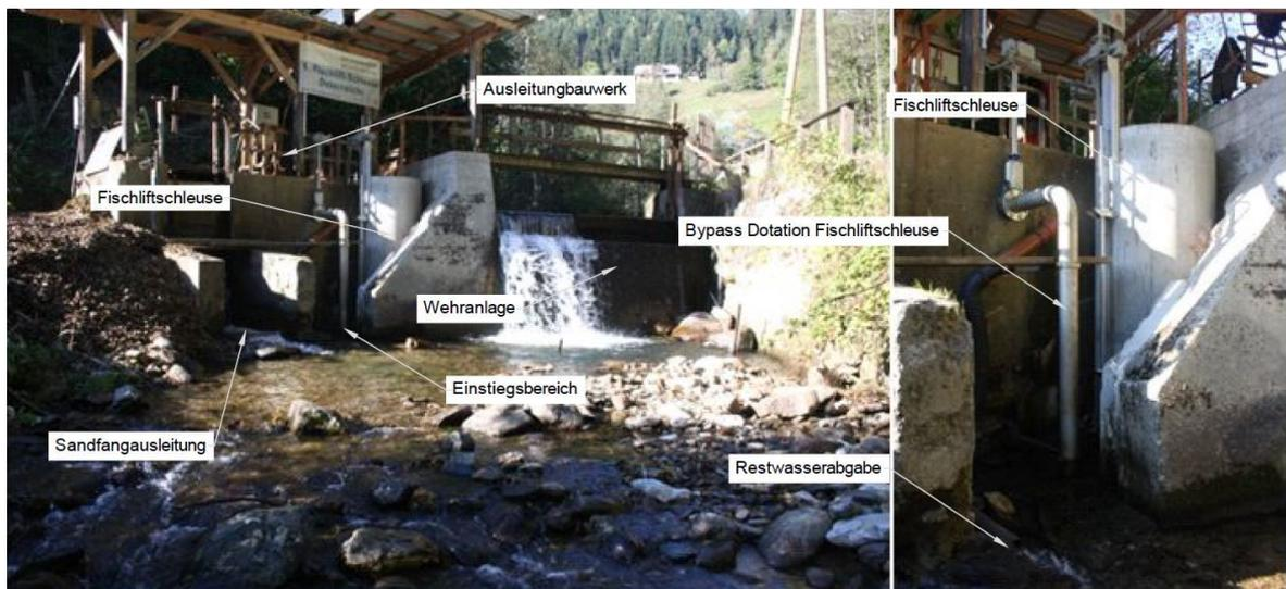
**Abbildung 5 Unterwasserseitige Aufnahme der Wehranlage KW Leser mit Fischliftschleuse; rechts ist der Einstiegsbereich in die Fischliftschleuse, mit der Bypassleitung für die Restwasserdotation abgebildet**
