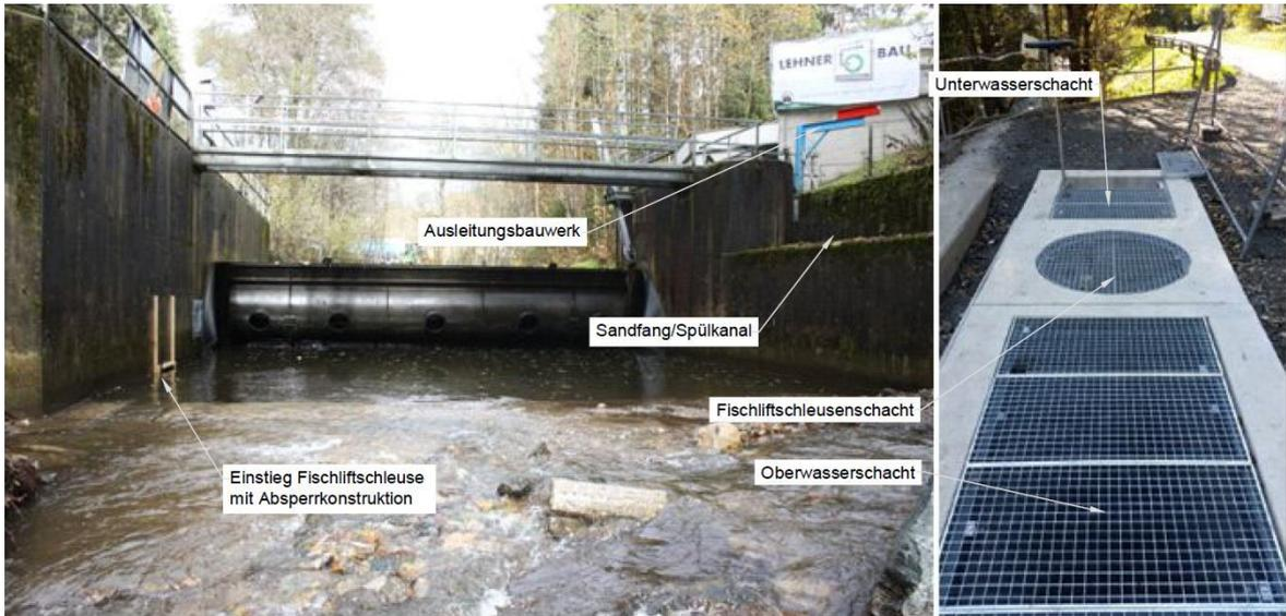
Abbildung 8 Aufnahme Wehranlage und Fischliftschleuse KW Vier-Linden; rechts Tosbecken mit Holzabsperung Einstieg in Vorschacht; links von oben nach unten: unterwasserseitiger Vorschacht, Fischliftschleusenschacht und OW-Schacht
