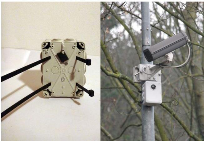
Abbildung 24: Feuchtraum-Abzweigkasten; Rückseite mit Kabelbindern für die Montage und montierter Feuchtraum-Abzweigkasten am Laternenmast (Quelle: CZACHS et al., 2014, S. 14)
