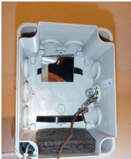
Abbildung 19: geöffneter Feuchtraum-Abzweigkasten (Quelle: CZACHS et al., 2014, S. 14)
