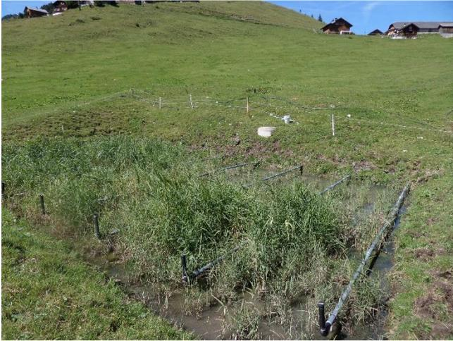
Abbildung 4-4: Erste Pflanzenfilterstufe
