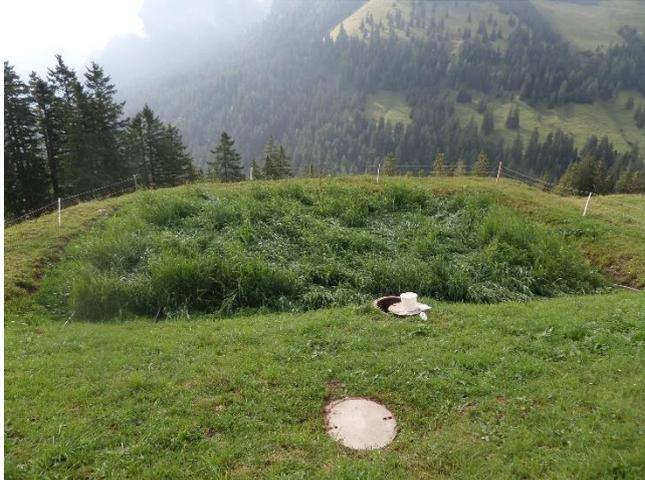
Abbildung 4-8: 1. Pflanzenfilterstufe
