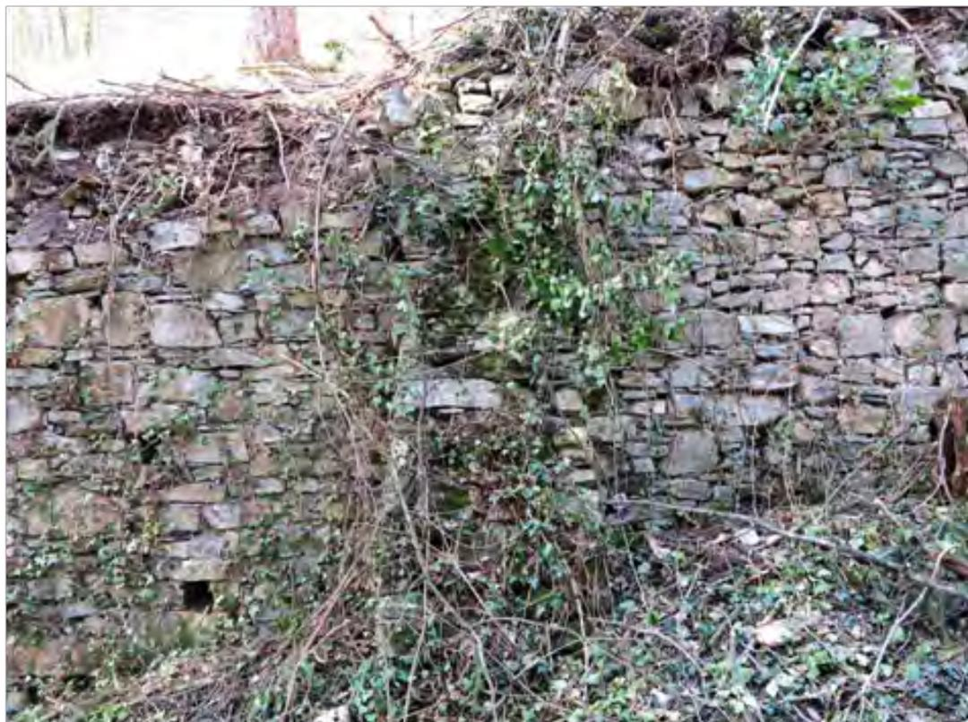
Abb. 33: Abschnitt B2 stellenweise regelhafter Verband mit rechteckigem Kalkbruchstein, Wasserauslass und Stützpfiler
