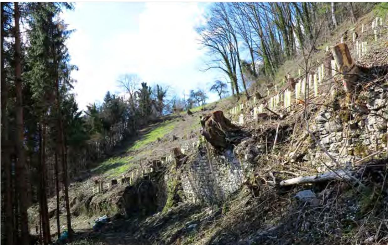
Abb. 1: Vanovagasse mit teilweise beschädigter Trockensteinmauer und darüber die Wiederaufforstung
