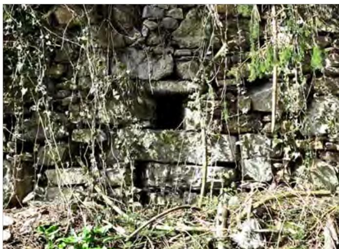
Abb. 38: typische Entwässerungsöffnung mit längeren, die Leerstelle überbrückenden Steinen oben und unten
