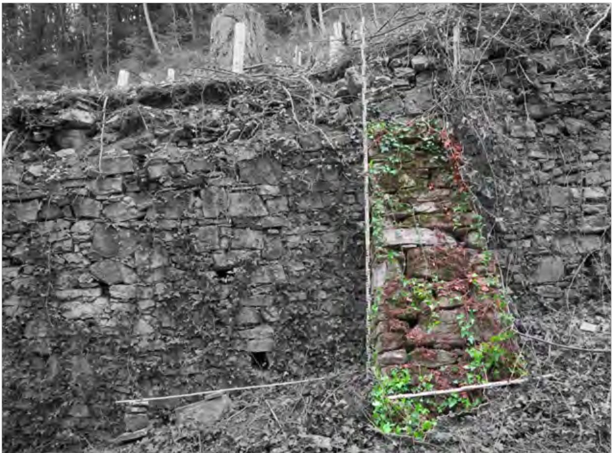
Abb. 36: Stützpfiler im Mittelbereich des Mauerkomplexes, Abschnitt B2 (Stützpfiler koloriert)
