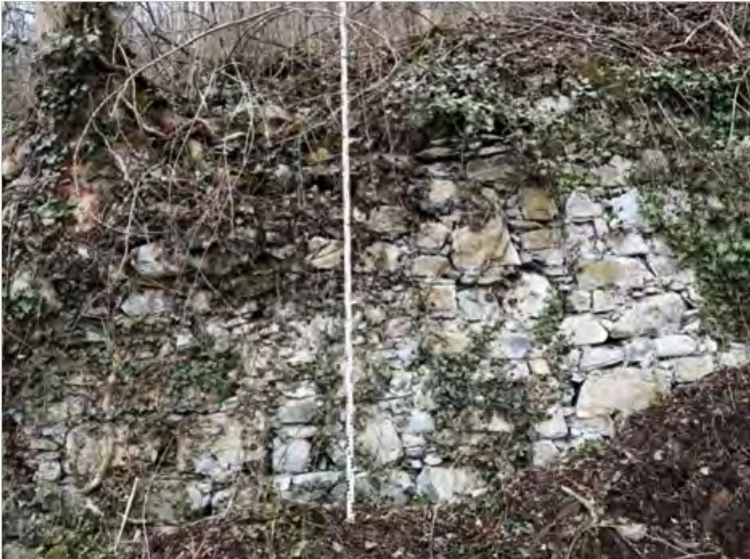
Abb. 32: Abschnitt B1 unregelmäßiger Verband mit unterschiedlich geformten Kalksteinen
