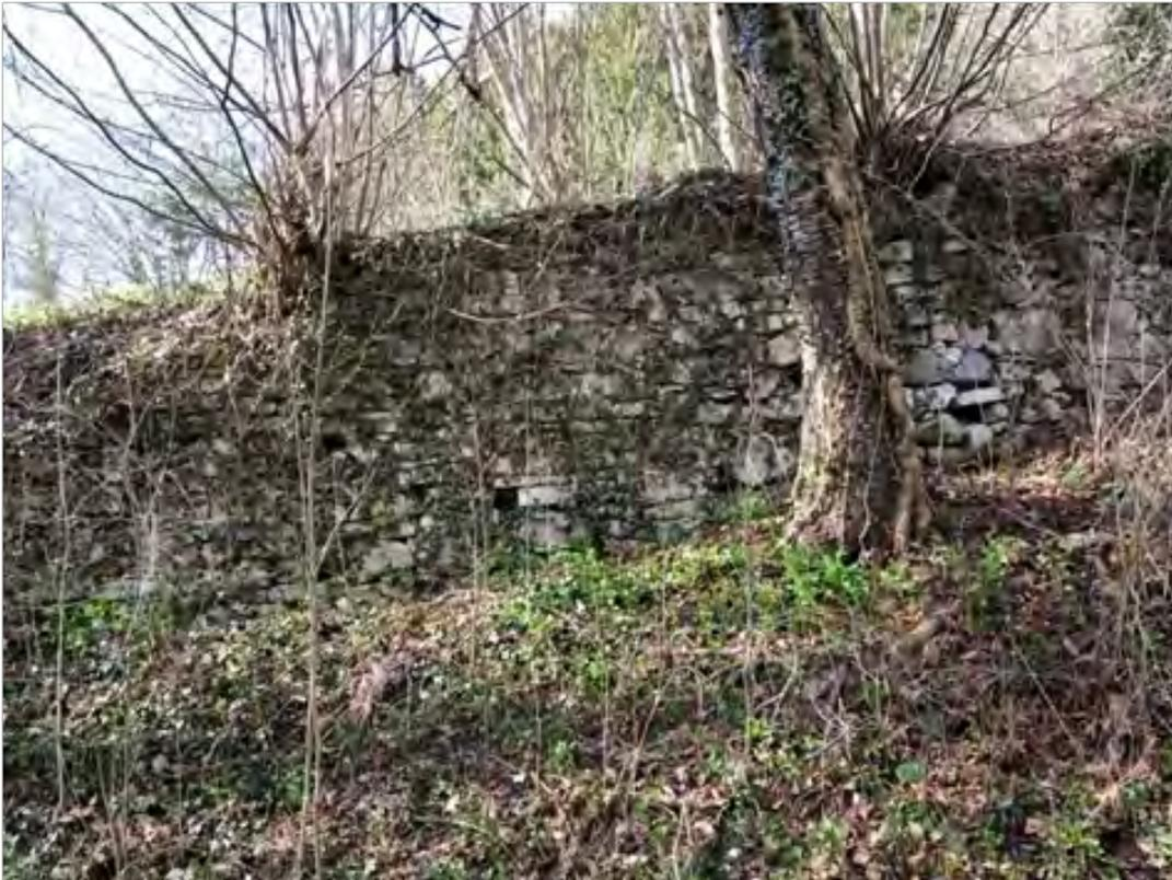
Abb. 34: Abschnitt T1 unregelmäßiger Verband mit unterschiedlich geformten Kalksteinen und silikatischem Gestein
