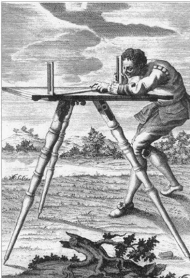
Abb. 4: Messtisch nach Marinoni, welcher für Vermessungsarbeiten für die Negrellikarten sowie den Franziszeischen Kataster diente
