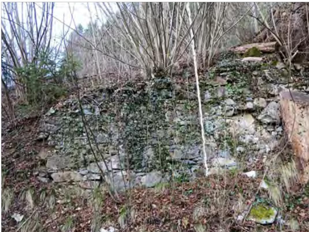
Abb. 35: Abschnitt T2 unregelmäßiger Verband aus unterschiedlich geformten Kalksteinen und silikatischem Gestein kleinerer Größe
