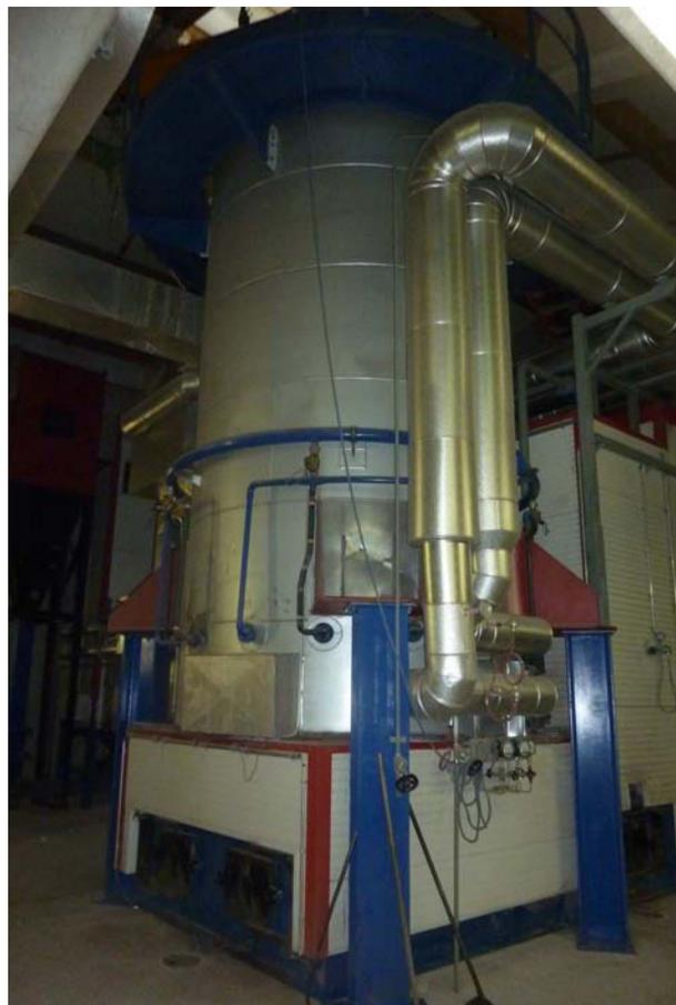
**Abbildung 2.3:** Thermoölkessel in Grossarl
