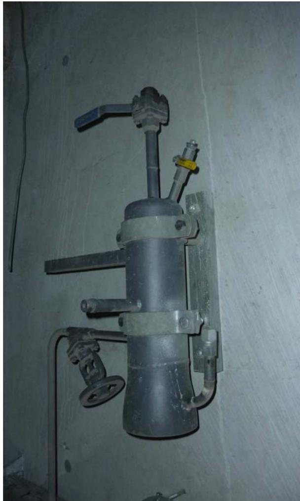
Abbildung 5.12: Probeentnahmestelle
