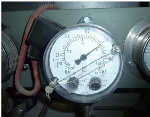
**Abbildung 5.6:** Strömungssicherung in der Beispielanlage Grossarl
