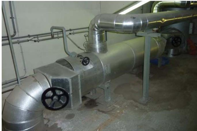
**Abbildung 5.4:** Betriebswärmeübertrager in Grossarl
