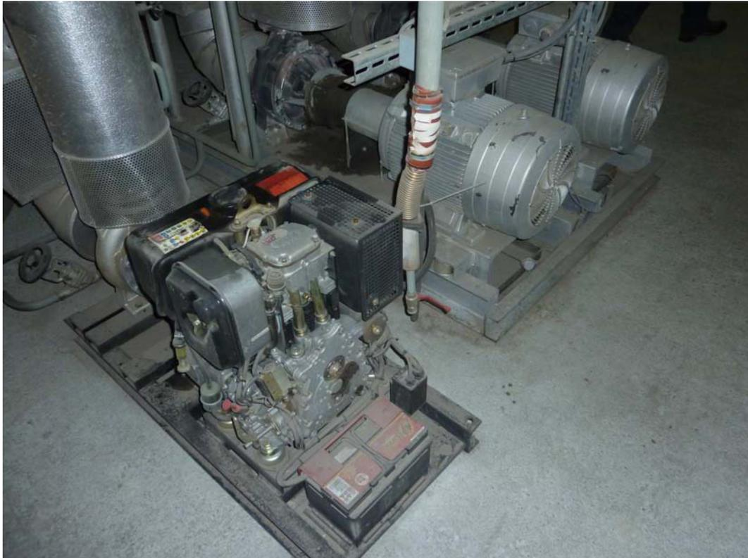
**Abbildung 5.11:** Notkühlpumpe und die beiden Umwälzpumpen
