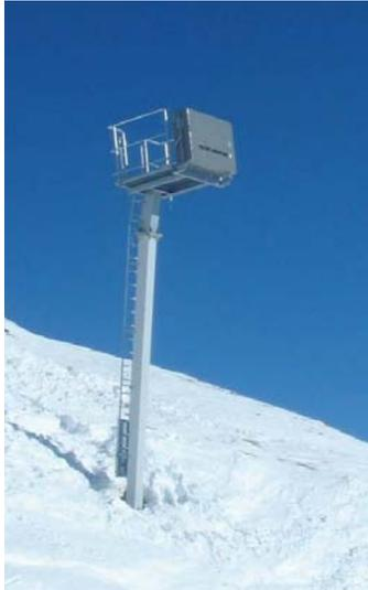
Abb. 5-5: Wyssen Mini-Sprengmast (Quelle: Wyssen avalanche control AG (o.J.))
