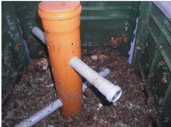
Abbildung 24: Solarkomposter Innenansicht gelochtes Zentralrohr mit Verzweigungen zur Warmluftverteilung, Kaunergradhütte, Quelle: SCHÖN, 2007
