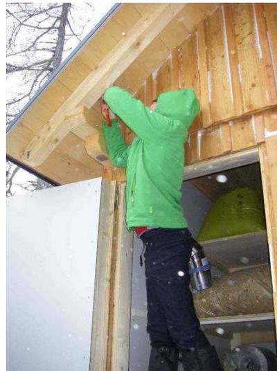
Abbildung 50: Sensormontage unterhalb des Dachvorsprungs im Außenbereich der Komposttoilette bei der Rieshütte
