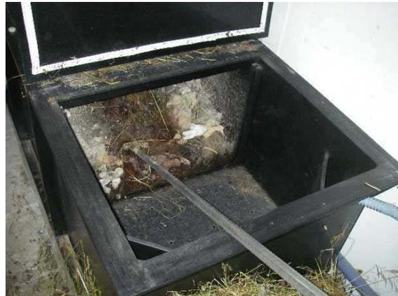
Abbildung 15: leere Nachrottekammer mit offenem Schieber
