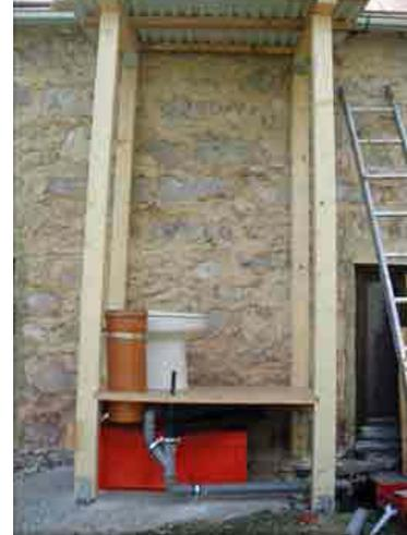
Abbildung 10: Separationstoilette mit externer Kompostierung in Bau, Bettelwurf Hütte
