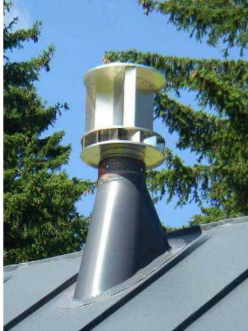
Abbildung 12: Dachentlüftung Savonius-Lüfter
