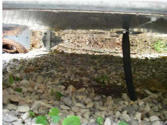
Abbildung 43: Sickerwasserableitung in den Untergrund
