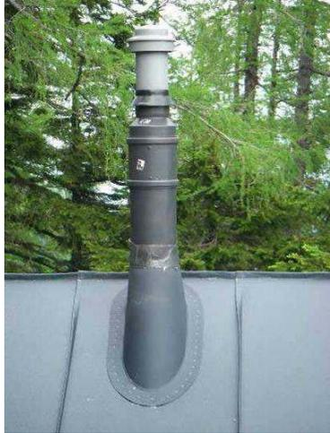
Abbildung 11: Dachentlüftung Regenabdeckung
